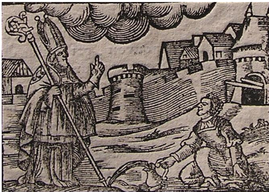
Saint Julien faisant jaillir la source au pied du mur d'enceinte.
