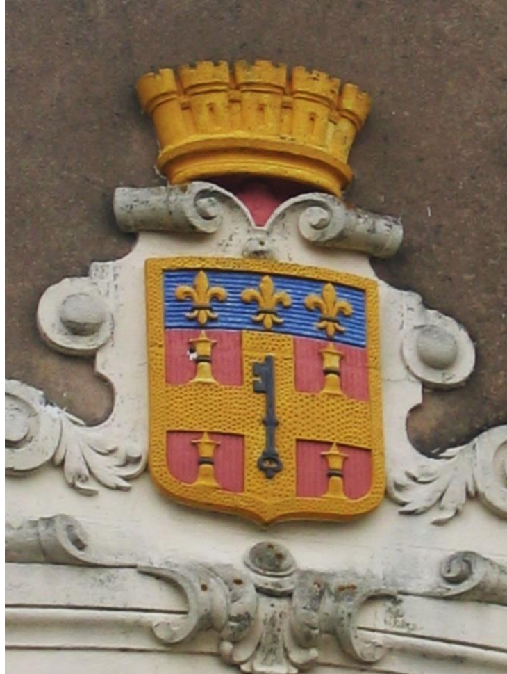
L'écusson figurant au fronton de l'usine des eaux.
